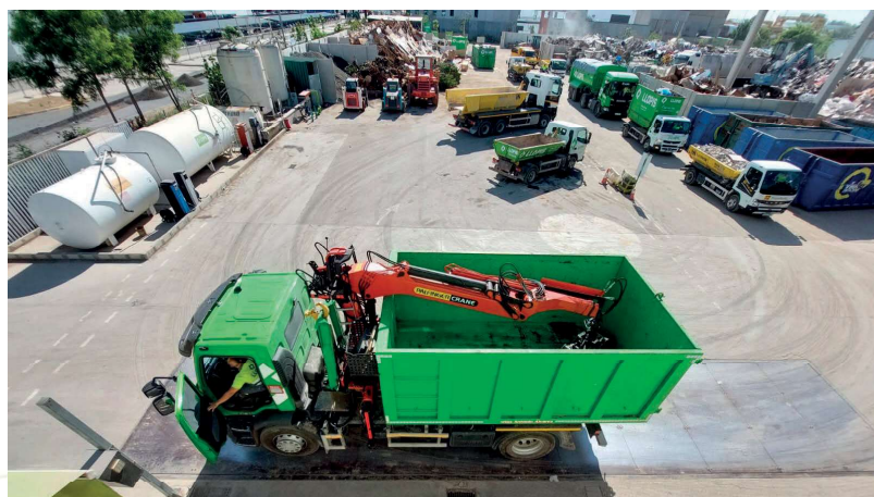
Planta de Transferencia de Residuos de Llopis Servicios Ambientales.
